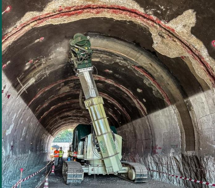
L'avanzamento è avviato tramite un pulsante e l'operatore dovrà solamente seguire la fase di lavoro fino al termine della passata. Tutto questo comporta risparmi di tempo considerevoli, una maggiore produzione oraria in metri cubi asportati e un minore impegno da parte dell'operatore che potrà seguire le operazioni a distanza da una posizione di sicurezza, lontana dalla zona di lavoro.
